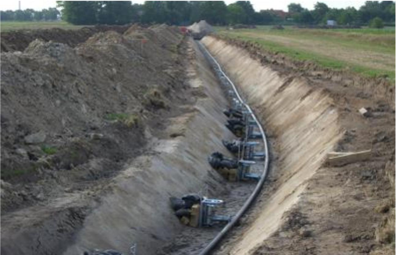
*Tranchée accueillant un câble électrique souterrain sur une parcelle agricole en chantier (source : Prysmian)*
